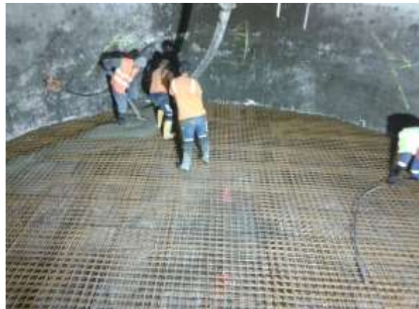
Práce ve vodojemu Ještěrka 1
