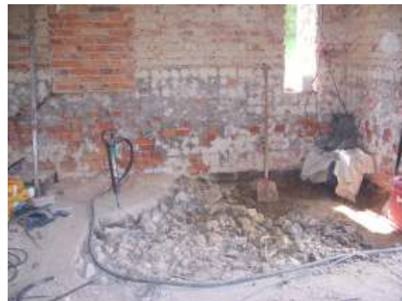
Interiér ČS Ještěrka 1 během prací
