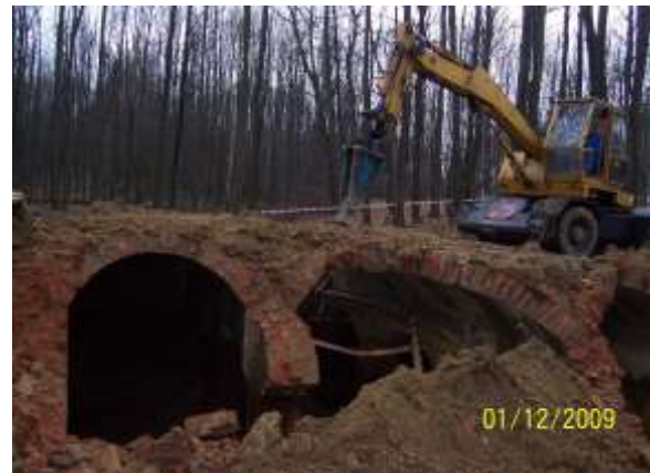
Demolice vodojemu Les (2009)
