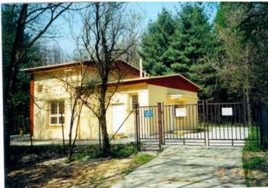
Objekt Ještěrka 2 po rekonstrukci budovy (2001)
