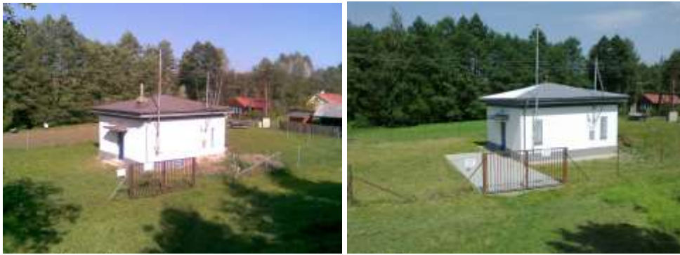
Oprava budovy Ještěrka 1 – před a po opravě (2013)
