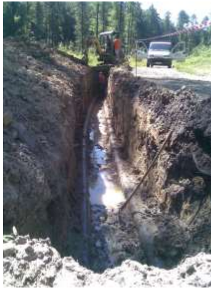
Narovnávání gravitačního potrubí
