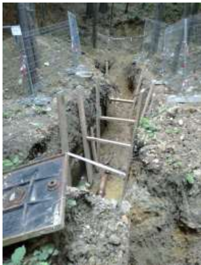
Rakovec 2014 – obnažení původního drénu u jímky 3 a zakrývání nového drénu
