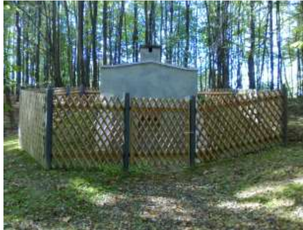
Zimnice - stav po opravě objektu (2011)
