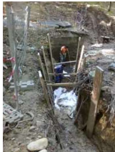
Rakovec 2014 – obnažení původního drénu u jímky 3 a zakrývání nového drénu
