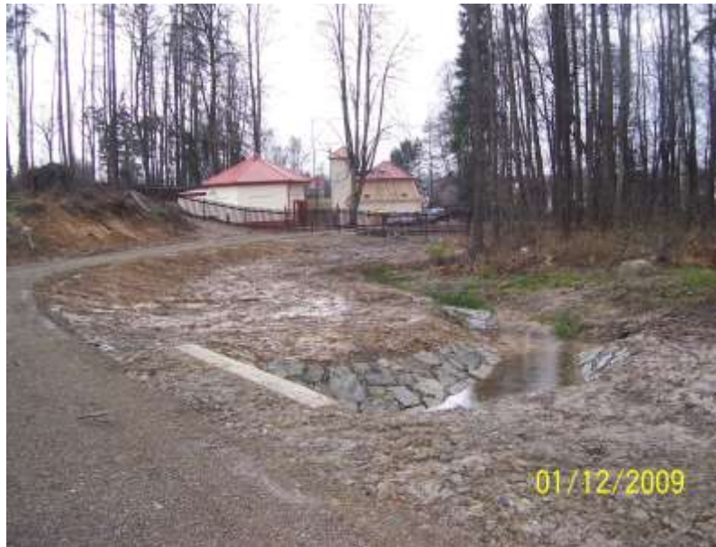
Stavba komunikace od bývalého vodojemu Les (2009)
