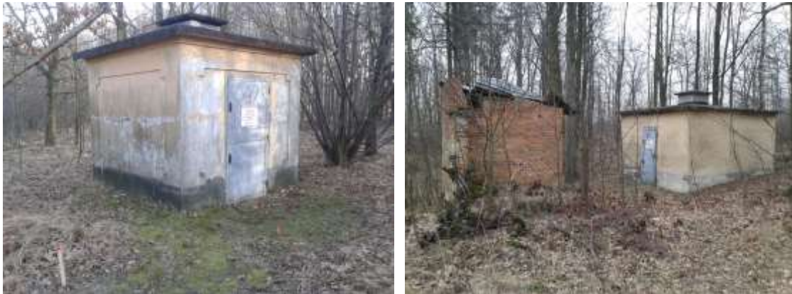
Studny 3 a 9 se zbytky budovy původní čerpací stanice v prameništi Les před rekonstrukcí (2018)
