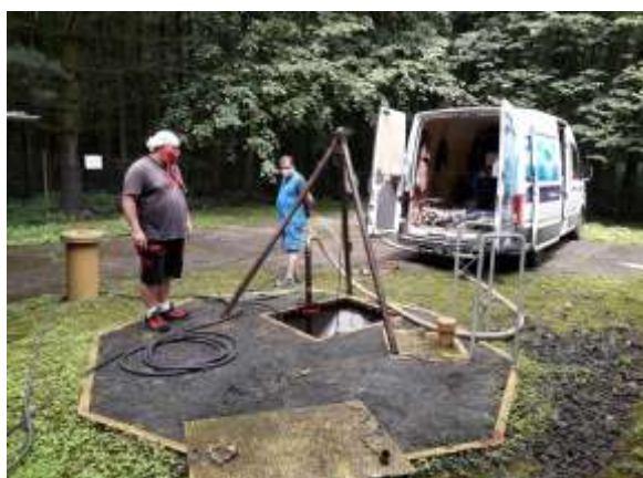
Čištění studny Ještěrka 2 metodou Hydropuls za použití dusíku (2020)
