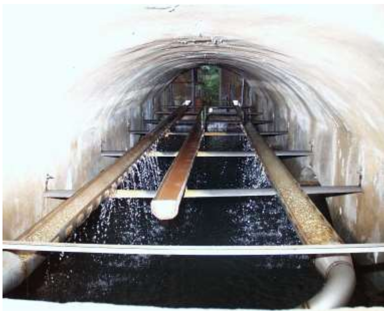
Instalace provzdušňovacích žlabů ve vodojemu Les (foto 2003)
