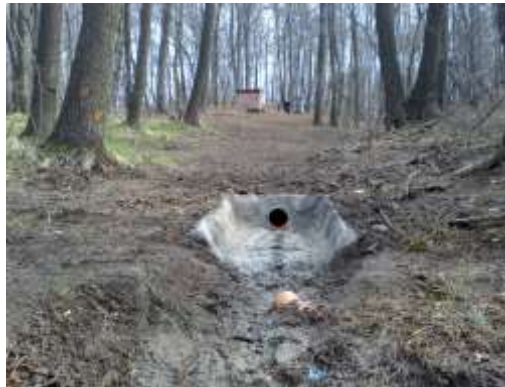
Rakovec – po výměně přepadového potrubí z jímky č. 4 (2011)
