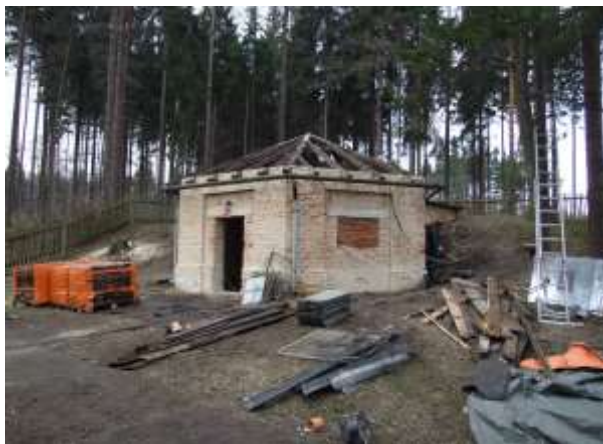
Sběrná studna během rekonstrukce (2009)
