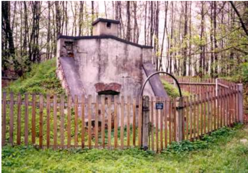
Vstupní objekt Zimnice (1995)
