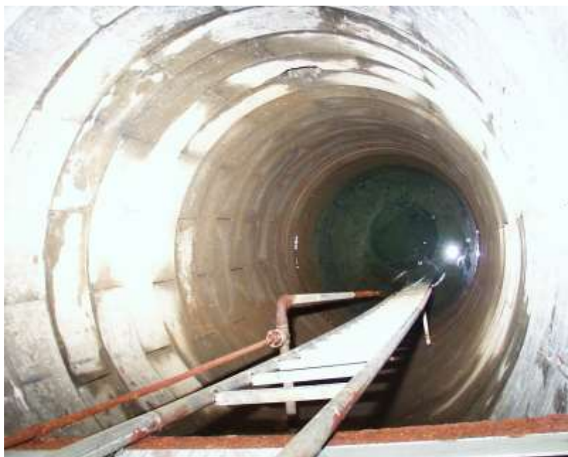
Interiér studny z roku 1926 (foto 2007)
