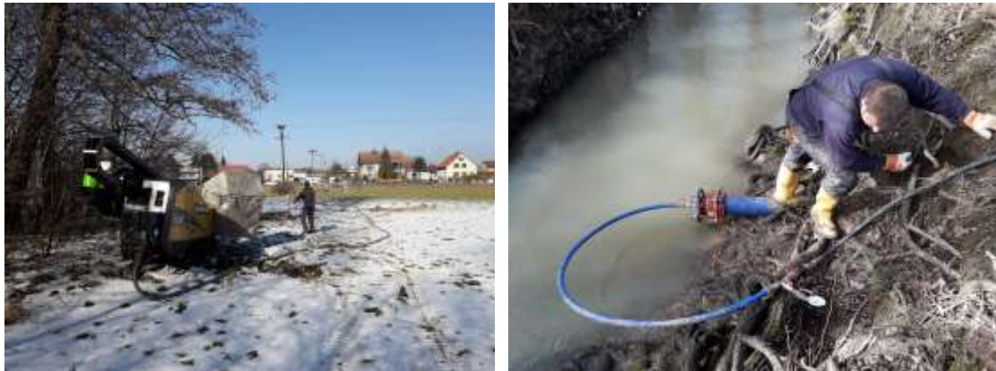
Realizace řízeného protlaku odkalovacího potrubí v Horních Datyních a tlaková zkouška potrubí (2021)
