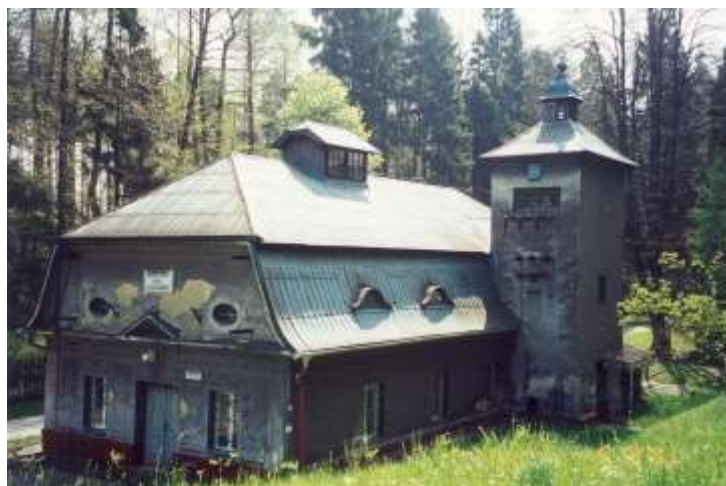
Budova čerpací stanice před rekonstrukcí (2008)
