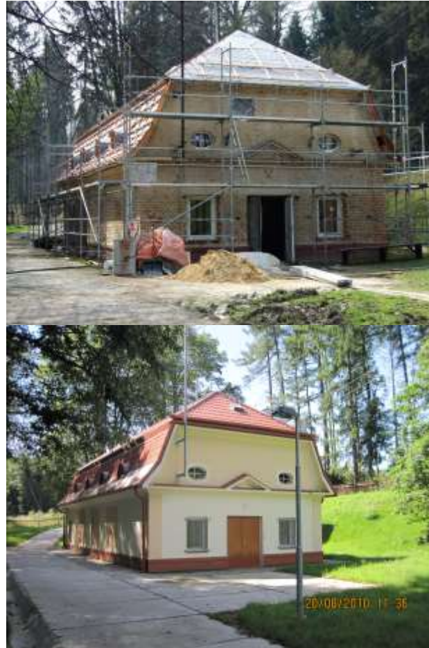
Budova čerpací stanice během rekonstrukce (2009); Objekt strojovny po rekonstrukci (2010)
