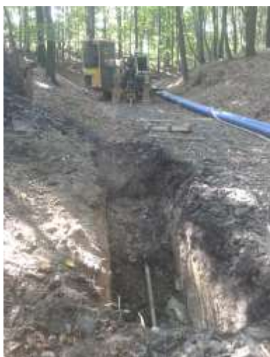
Poblíž zdroje Zimnice – příprava potrubí pro zatažení; zatahování potrubí
