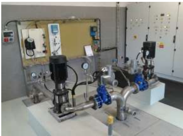
Interiér ČS Ještěrka 1 po opravě
