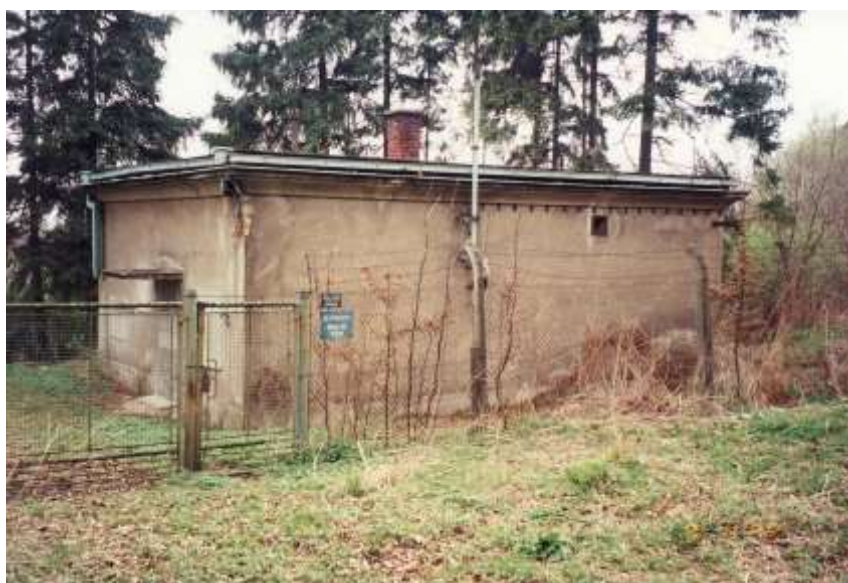
Úpravna vody Záryje – foto před demolicí v r. 2005
