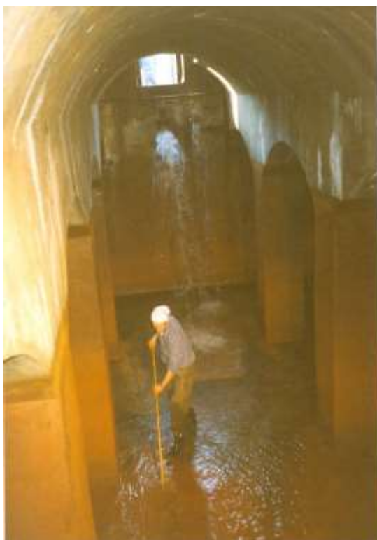
Čištění vodojemu Důlnák – Les (1995)
