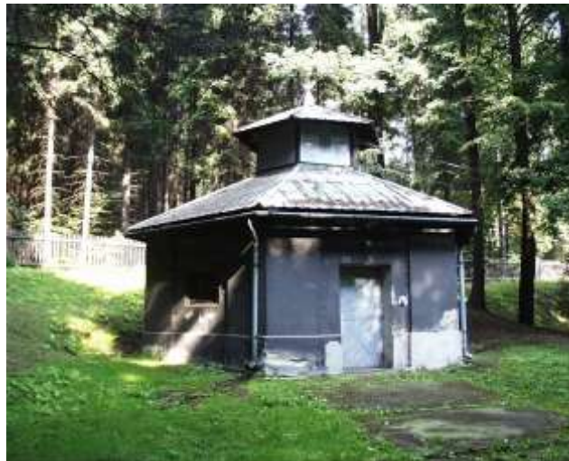
Sběrná studna před rekonstrukcí (2008)
