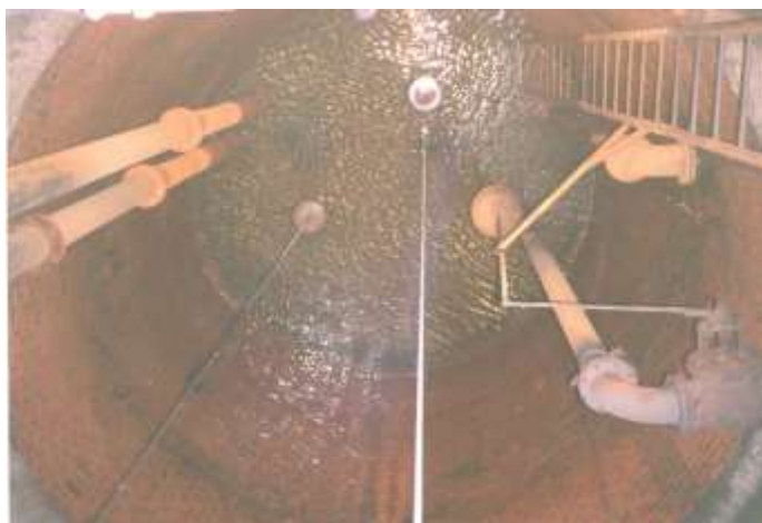
Sběrná studna – interiér (1996)
