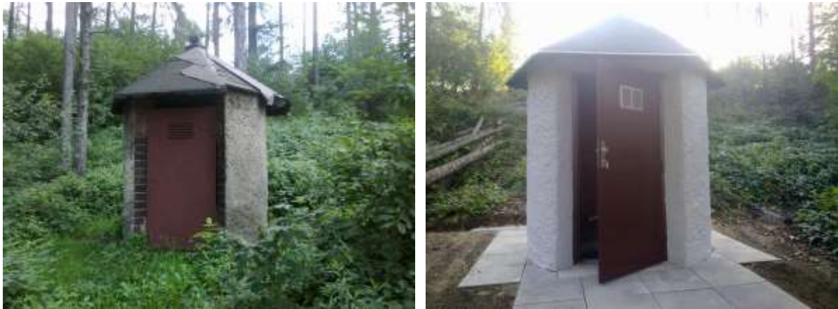
Stará Datyně - měrný objekt před a po opravě (2011)
