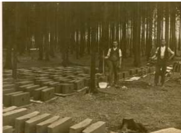
Výroba cihel a výstavba sběrné studny u čerpací stanice Důlnák (1923)
