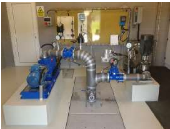
Ještěrka 1 – výměna čerpadla (vlevo)
