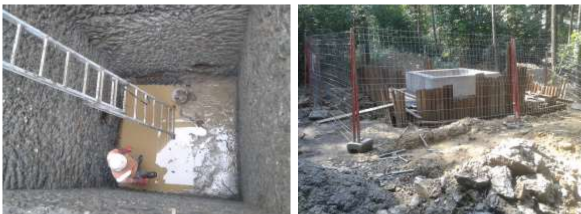
Rakovec – oprava pramenních jímk (2018-2019)
