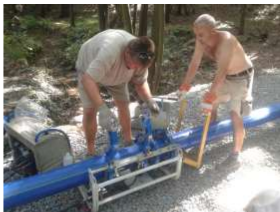
Poblíž zdroje Zimnice – příprava potrubí pro zatažení; protlačování budoucí trasy potrubí
