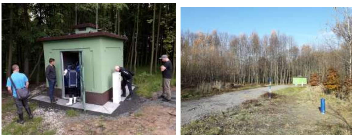
Prameniště Les – prohlídka před dokončením stavby (2019)
