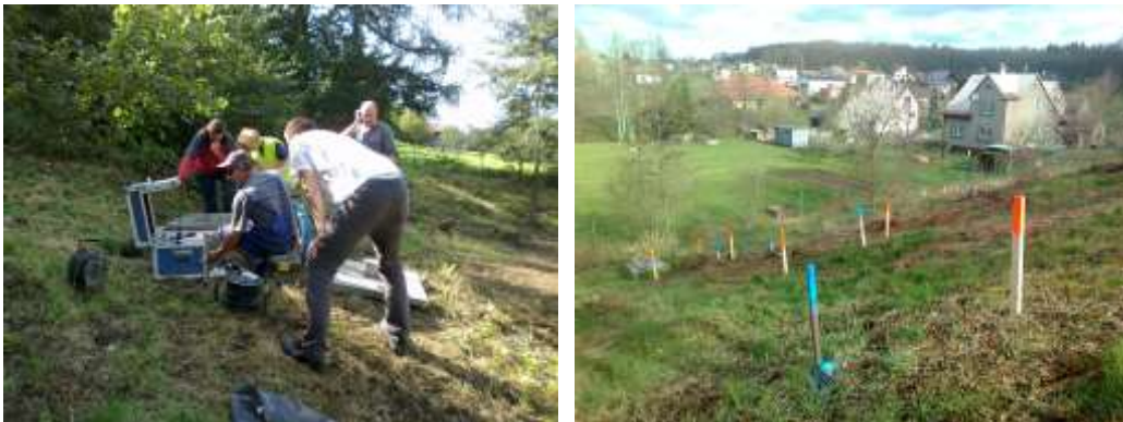
Kamerové prohlídky jímácích zářezů a jejich vytyčení - Ještěrka1 (2014)
