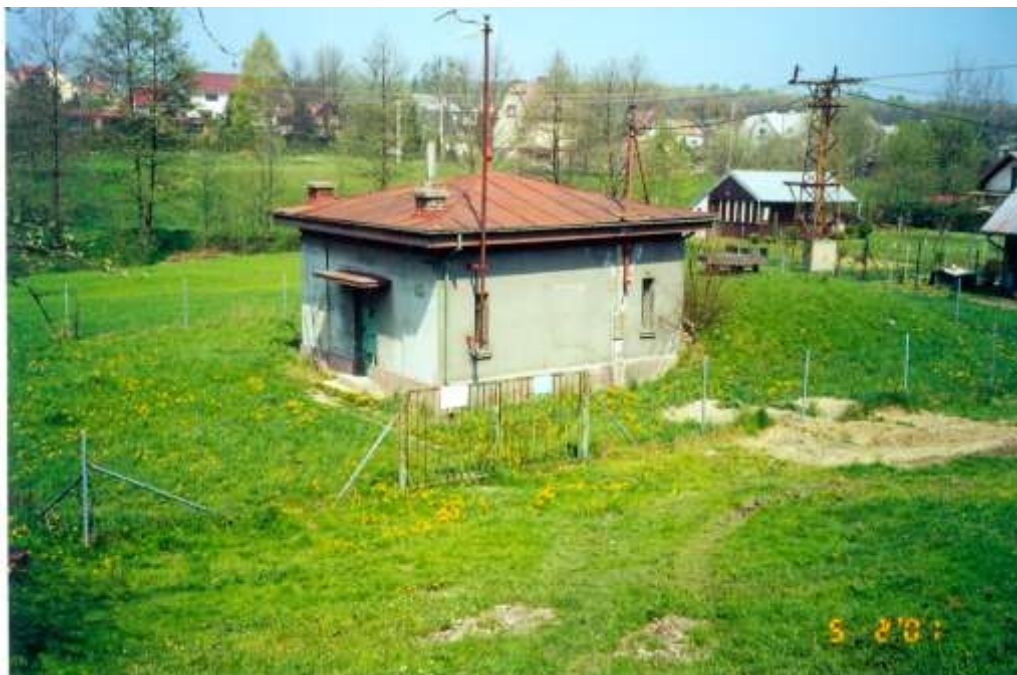
Budova čerpací stanice Ještěrka 1 se zemním vodojemem (foto 2001)
