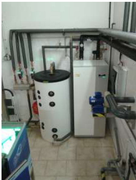
Tepelné čerpadlo – Ještěrka 2 (2015)
