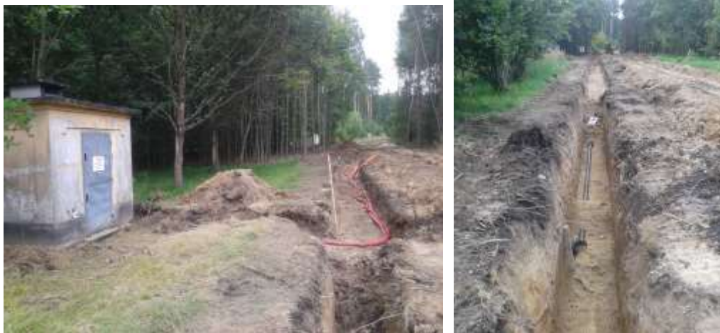
Prameniště Les - pokládka kabeláží a nového výtlačného potrubí na řadu 1(2018)
