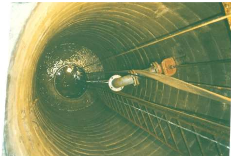
Čištění studny 2 po povodňovém stavu v roce 1997
