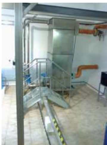
Aerační věž na Ještěrce 2 po rekonstrukci (2012)
