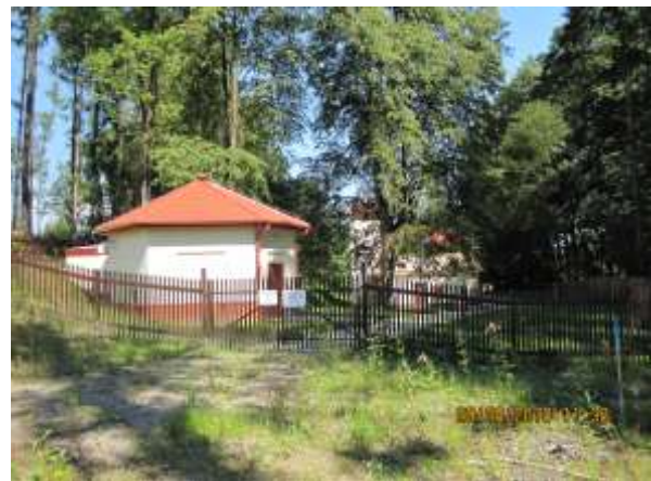
Objekt sběrné studny po rekonstrukci (2010)
