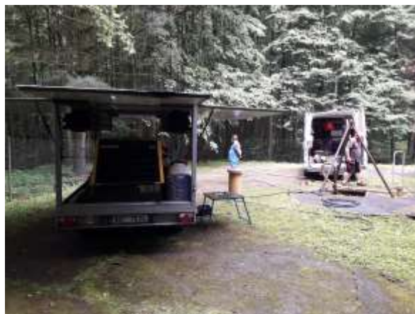
Čištění studny Ještěrka 2 metodou Hydropuls za použití dusíku (2020)
