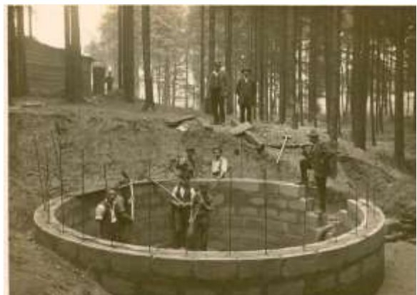
Výroba cihel a výstavba sběrné studny u čerpací stanice Důlnák (1923)
