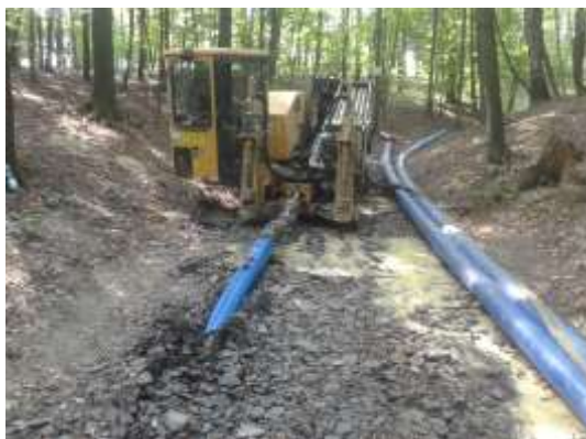
Poblíž zdroje Zimnice – příprava potrubí pro zatažení; zatahování potrubí
