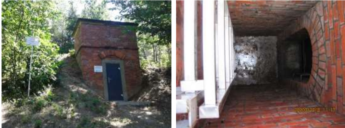
Stará Datyně 2016 – vstupní objekty po opravě
