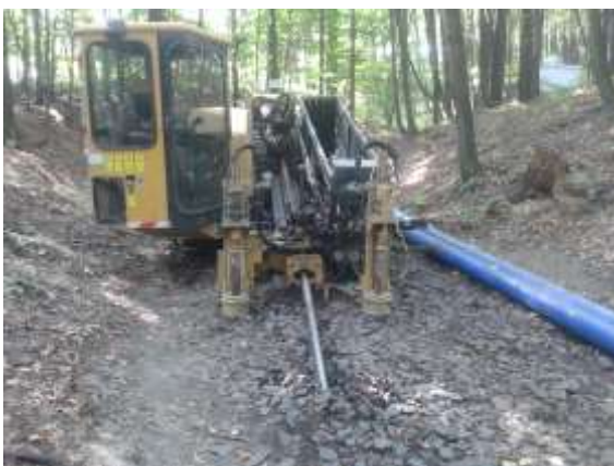
Poblíž zdroje Zimnice – příprava potrubí pro zatažení; protlačování budoucí trasy potrubí
