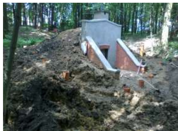
Zimnice – během opravy objektu (2011)
