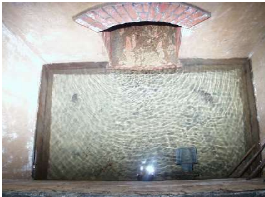
Vyústění podzemní štoly do sběrné jímky Zimnice (2008)
