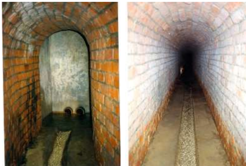
Stará Datyně – vyústění jímacích zářezů do podzemní štoly (1997); podzemní štola (1996)
