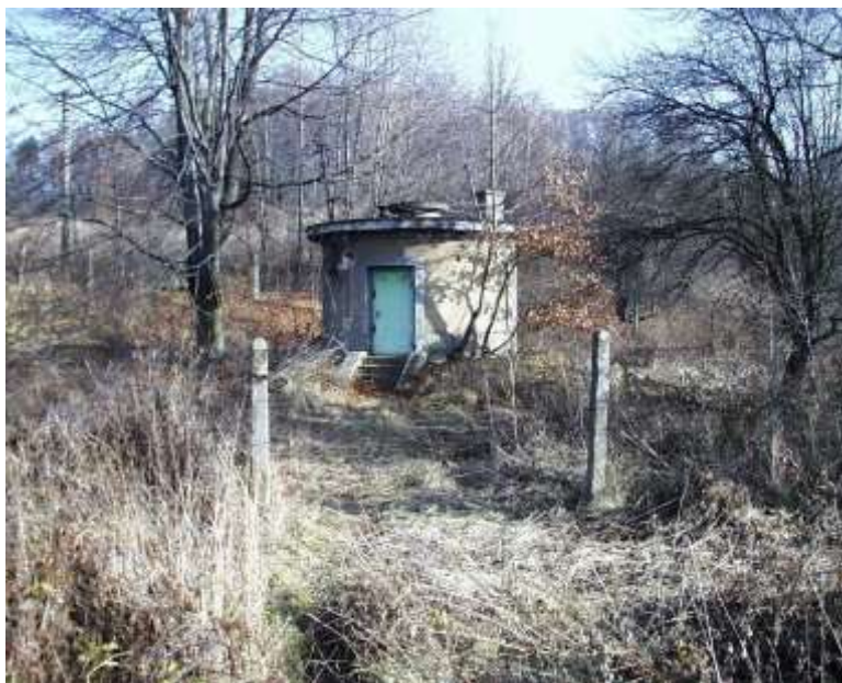
Kunčická studna před demolicí (1995)
